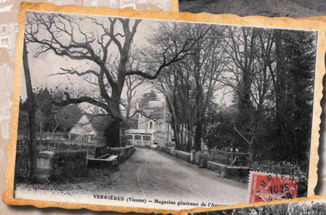
LE PONT ET LES MAGASINS GÉNÉRAUX DE L'ANNEXE
